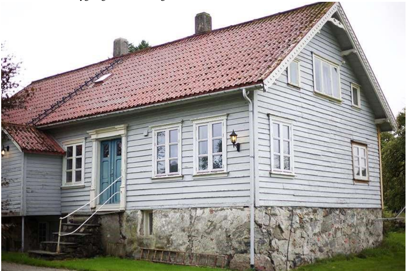
Hovudbygningen på Fossan, gnr. 41/3, har omfram historisk interesse fordi det fungerte som posthus like fram til 1961.
