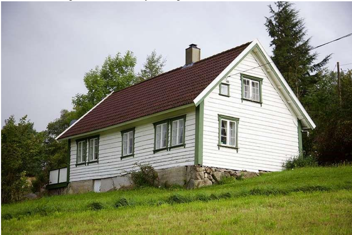
I Ytre Skeivika finn vi eit av dei meir autentiske husa i Forsand. Huset ser ut til å ha både original kledning og originale glas med listverk og detaljar god i behald, men det har fått betongstein på taket.
