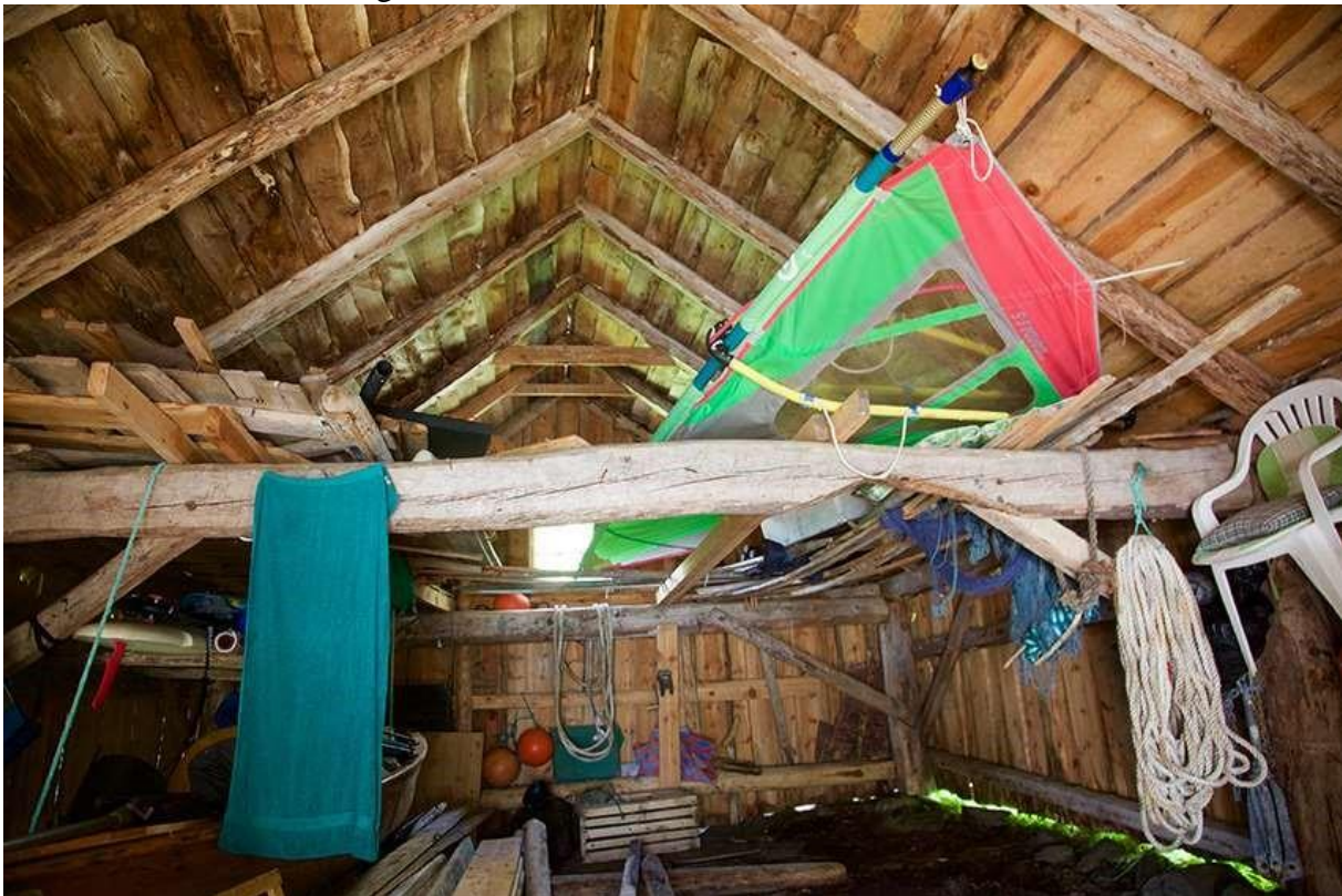
Stavkonstruksjon (med nogo attåt) i naustet på Norland.
