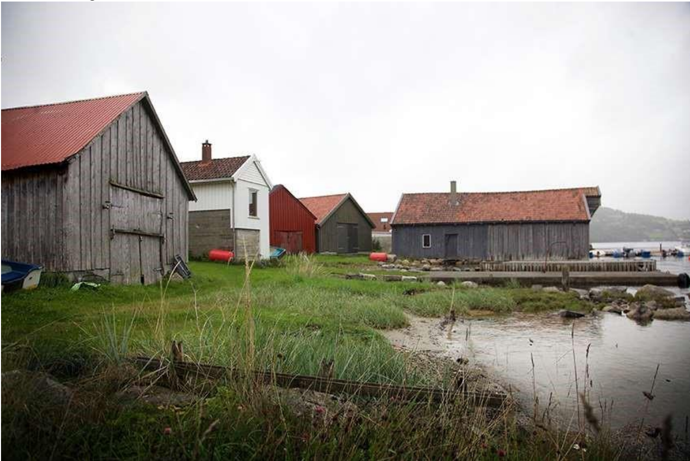
Sjøhusmiljøet i Bergevik er verna gjennom regulering til bevaringsformål.
