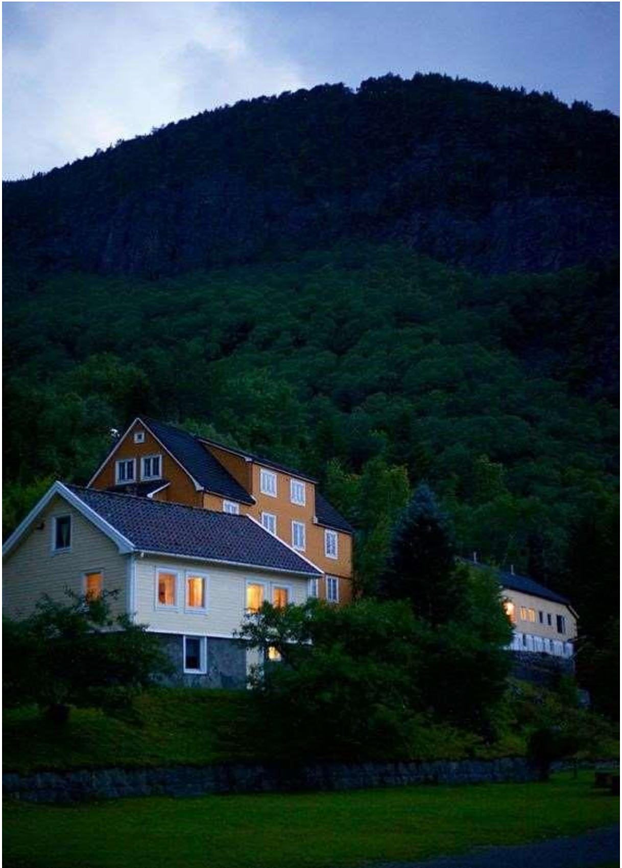
Dei fleste husa i Flørli har vore gjenstand for jamnt vedlikehald fram til nedlegginga på slutten av 1990-talet, men det manglar ein plan for systematisk vedlikehald og oppgradering til bruk for reiselivsformål.
