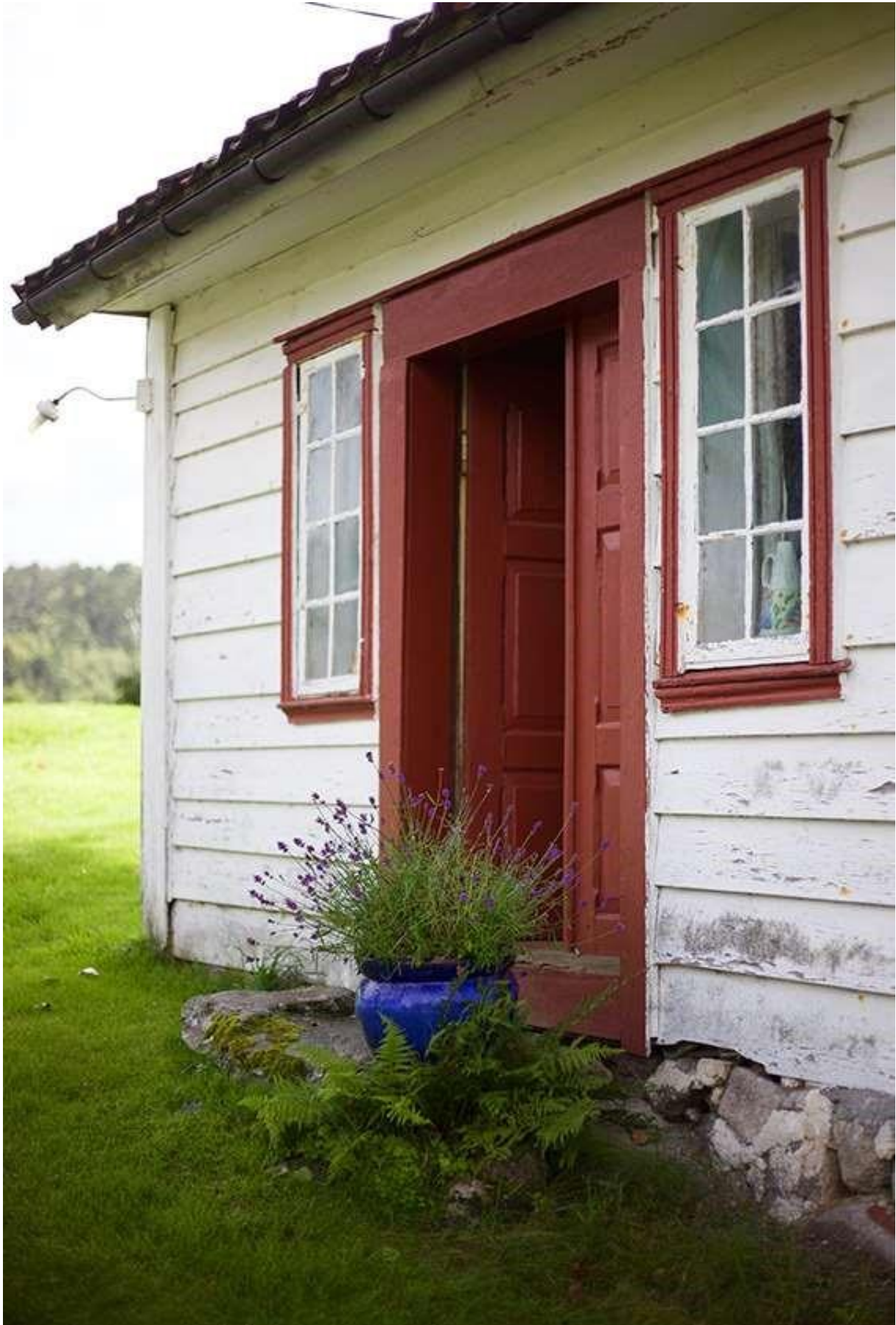
I den gamle hovudbygningen på Meling står det framleis glas som var typiske i klassisismen, med 4 glas parvis i høgda.
