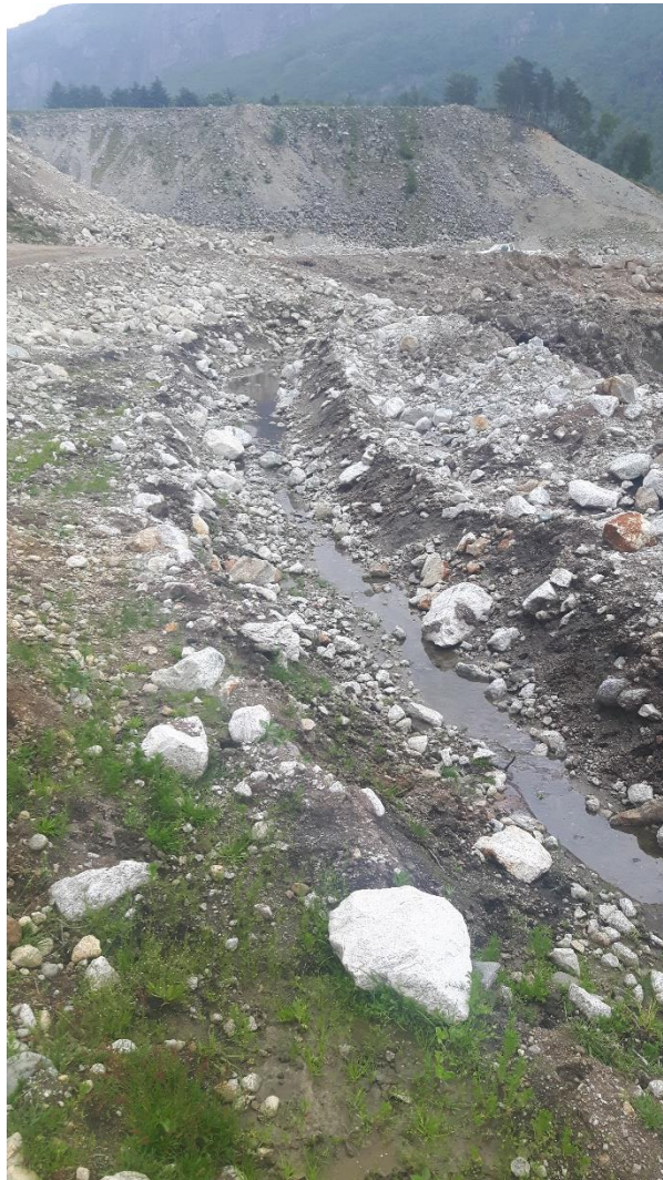
Figur 11: Gravd grøft for bortledning av hengende grunnvann i sørvestre del av eksisterende grustak.
