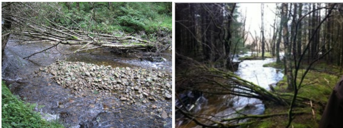
Figur 5-1 Typisk utforming av elv etter omlegging
