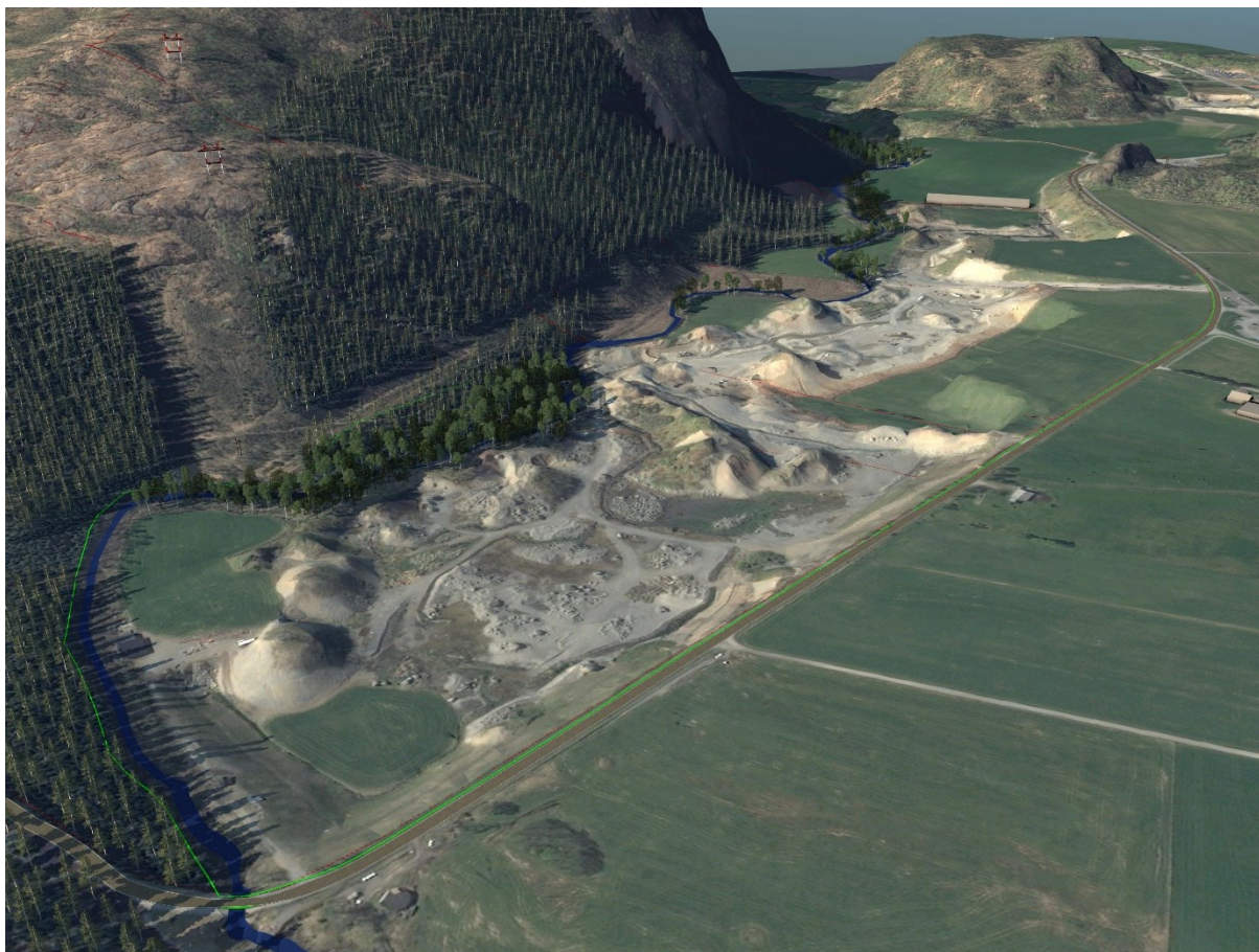
Figur 7-8 Uttaket under drift. Bildet er generert etter bilder fra 2015, og området er noe endret siden den gang (Asplan Viak AS).
